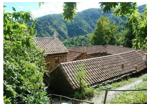
△ Le couvert végétal est maintenu mais éclairci pour disposer de vues et d'ensoleillement au niveau des espaces extérieurs
