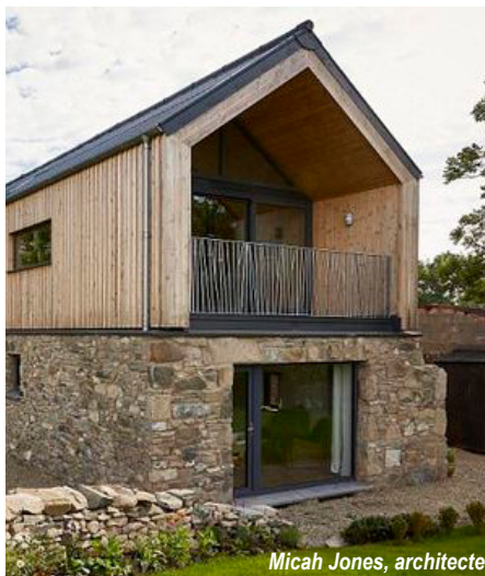
△ Surélévation ossature bois
