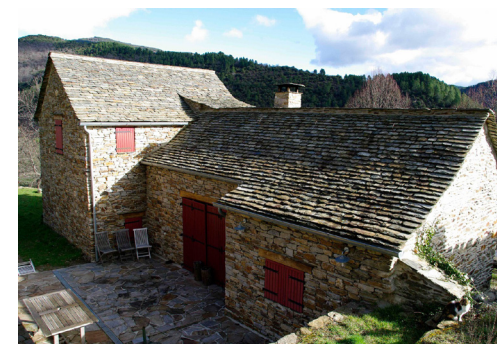
△ Habitat individuel implanté en relation étroite avec la pente : Source : Nathalie Crépin architecte
