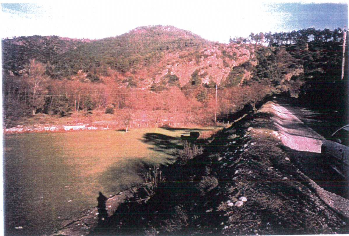
Gardon Ste Croix crue de 1958, laisse n°3
